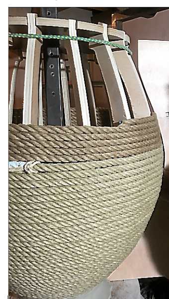
La corde de chanvre est enroulée de bas vers le haut sur le gabarit qui est ensuite recouvert d'une couche régulière d'argile.
